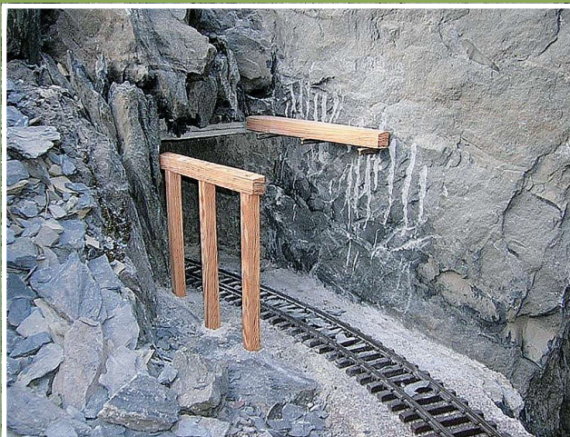
Einbau eines Tunnelportales aus Holzbalken.
