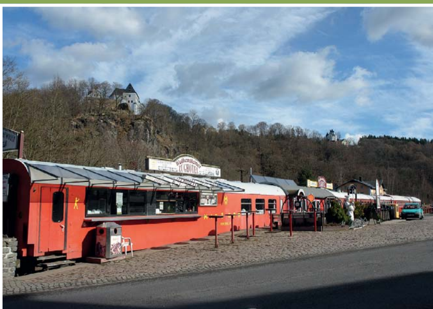
Blick von der Straßenseite auf das Zughotel.
